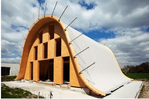
Figure 10 : Maison vague en cours de construction (Source http://www.batiactu.com )
