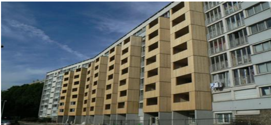
Figure 17 Loggias en Leno à Bondy (Source MetsäWood)
