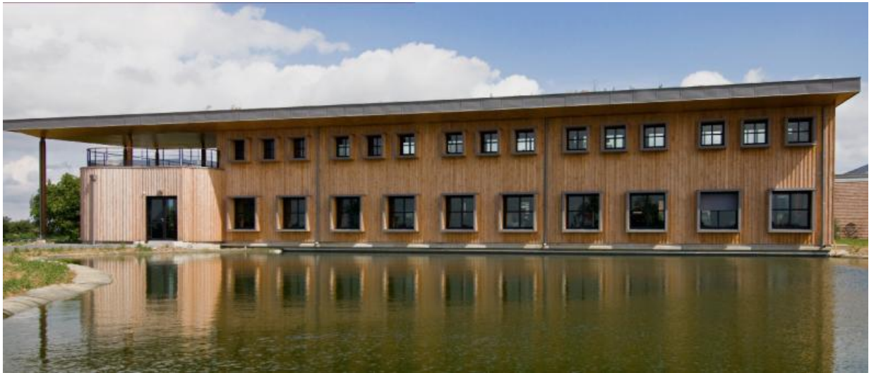
Figure 16 Siège de Millet Menuiseries en LENO (Source Magazine wOOD n°2 de MetsäWood)
