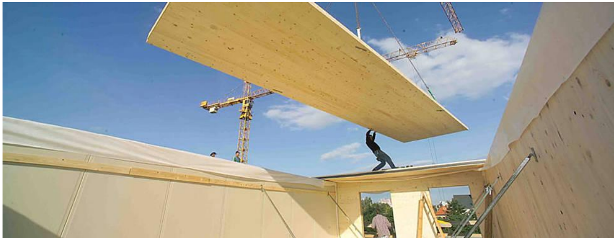
Figure 11 : Installation d'un panneau KLH (source KLH)
