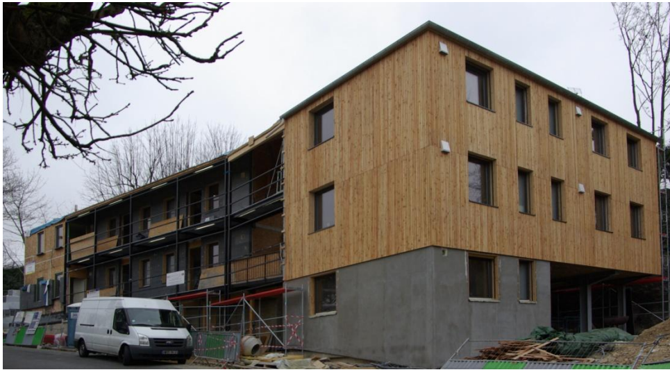
Figure 14 Chantier Woodeum à Conflans Ste-Honorine en BMR-T (Photo JFP)
